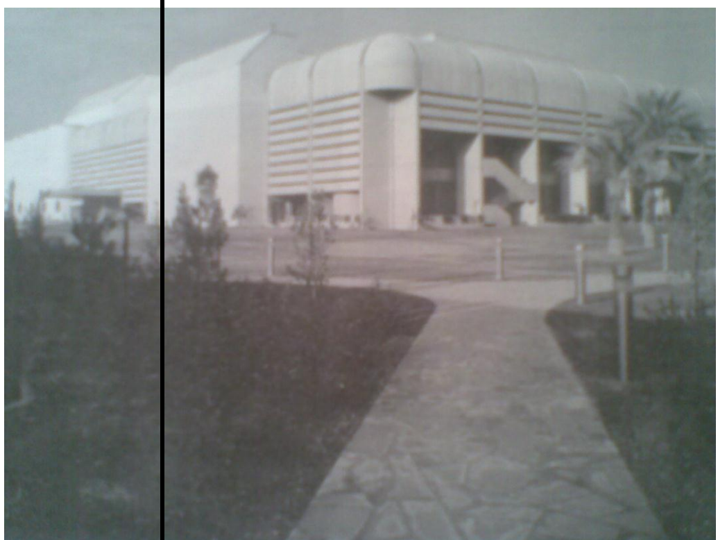
شكل (4) مبنى قصر المؤتمرات/بغداد/المعمار هيكي سيرين/1978-1982(تناص معماري،2007،ص53)
